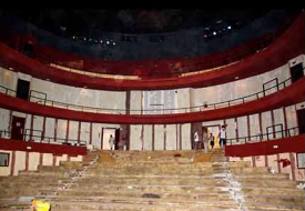
La salle en travaux (Documentation Service Communication - Ville de Bastia)
