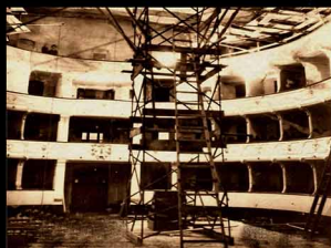
La grande salle en travaux, dans le courant des années 1930 (Documentation Comité des Fêtes et d'Animation du Patrimoine de Bastia)
